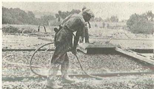
Fig. 26. Vibrering af vejkanter med pervibrator.
